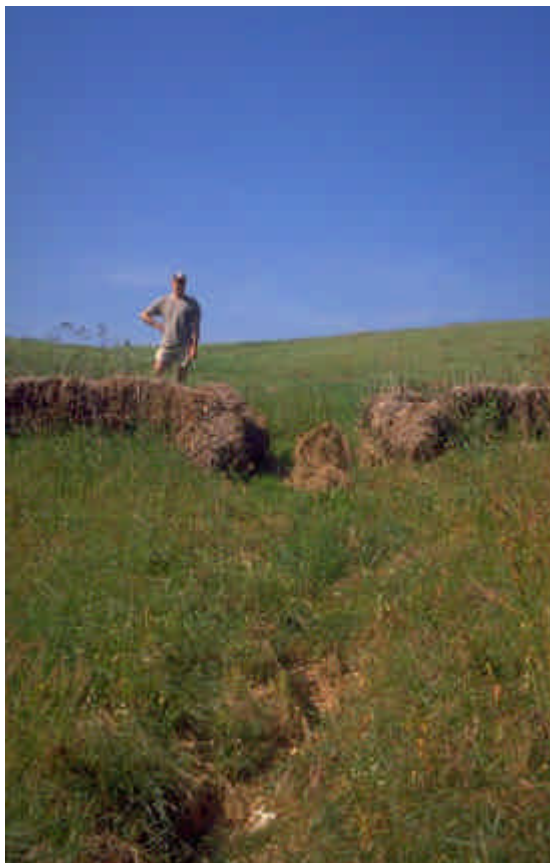
Photographie 18 : Diguettes en paille en travers de talweg, vue de l'extrémité de l'ouvrage depuis l'amont (Bassin de l'Andelle, département de l'Eure); Y.Nedelec.
