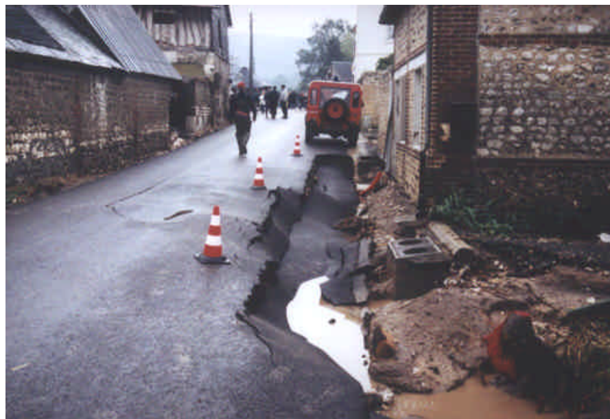
Photographie 15 : amplification des effets du ruissellement par la voirie en Haute-Normandie ; C. Douyer.
