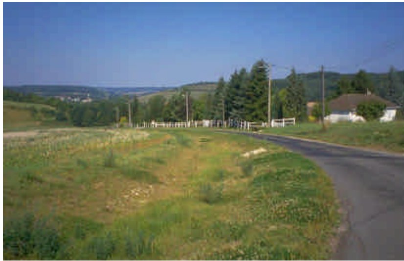
Photographie 17 : Bande enherbée canalisant et freinant le ruissellement entre des parcelles et une route bordée d'habitations. (Bassin de l'Andelle, département de l'Eure); Y.Nedelec.
