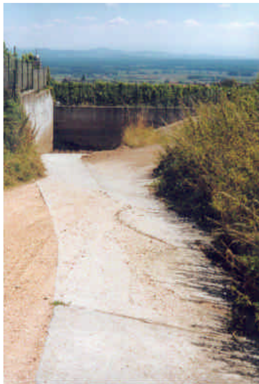
Photographie 16 : bassin de rétention des sédiments dans le vignoble champenois ; Y. Le Bissonnais .
