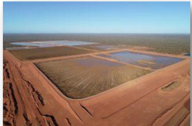
Bassins de stockage et évaporation
