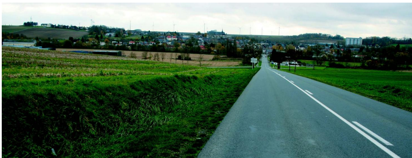
Covisibilité pénalisante entre un monument historique et un parc éolien - Montcornet (02) .
