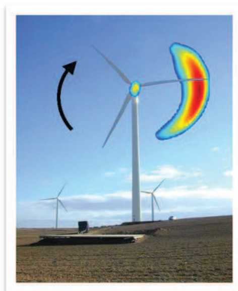
Figure 4 : Les sources de bruit d'une éolienne
