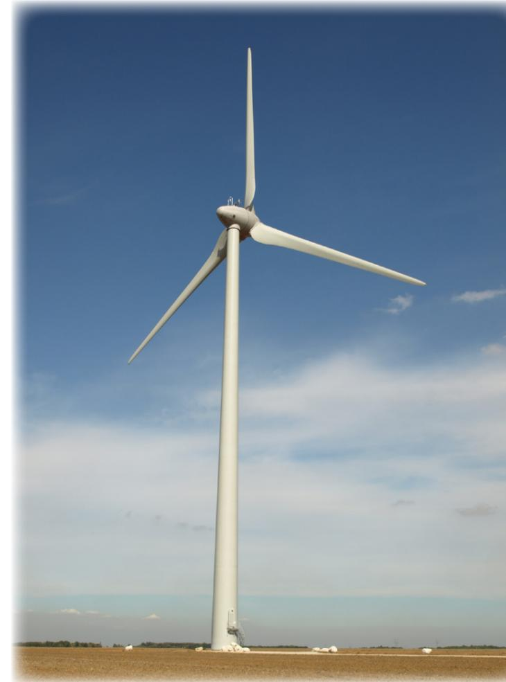
**> 50 mètres :** le « **grand éolien** », on utilise des machines à axe horizontal ; elles se composent, dans la plupart des applications, d'un rotor tripale.
