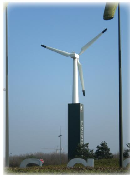
**12 à 50 mètres :** Le « **moyen éolien** », intermédiaire, est caractérisé par une production énergétique de l'ordre de 36 à 1500 kilowatts. L'implantation d'éoliennes de plus de 12 mètres de haut est soumise à permis de construire et à procédure ICPE à déclaration ou autorisation selon les caractéristiques de l'installation.
