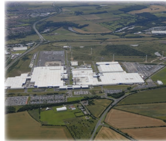
Développement en ponctuation - Usine Nissan - GB
