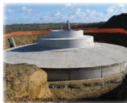
Source : Théolia chantier parc de Pussay (91)
