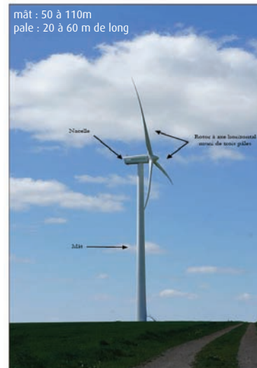
Fig. 1 : Description des éléments d'une éolienne
